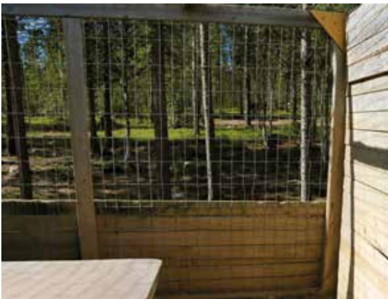
Laudoitetut väliseinät tuovat lisää rauhaa ja tarjoavat myös suojaa auringolta ja tuiskulta.
