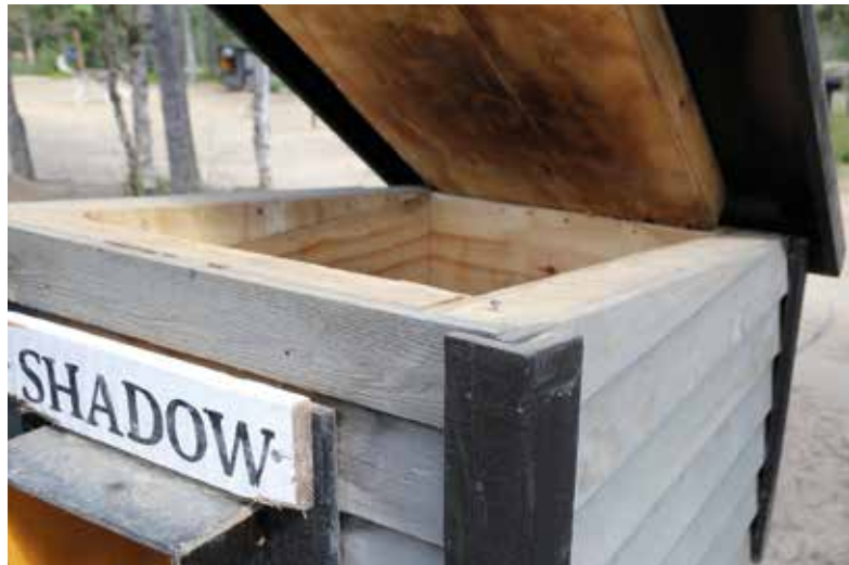
Ruuveilla voi kohottaa kattoa kosteuden poistamiseksi kopista.
