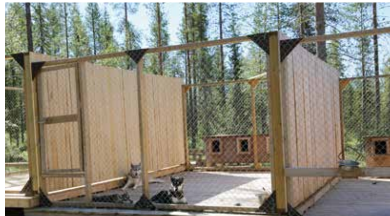
Riittävän tiheä verkko häkeissä ehkäisee tehokkaasti häkkien välisiä tappeluja ja rauhoittaa antamalla näkösuojaa. 5 x 5 cm väestösuojaverkko on kestävä ja jäykkää, eivätkä koirat saa venytettyä sitä isompisilmäisten tapaan.
